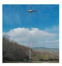
autres. Trois techniciens étaient suspendus pour réceptionner les modules. Ce pylône a reçu sa peinture finale qui lui permet maintenant de mieux se fondre dans le décors naturel avant le positionnement de la première antenne mobile de l'opérateur Orange. Cette antenne va permettre de supprimer la zone blanche aux Planches afin d'optimiser la couverture mobile, notamment dans les lieux publics que sont les commerces, la salle d'animation, le cabinet médical et les autres professions libérales.
